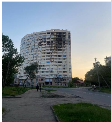
Рис. 2 Будинок на вул. В'ячеслава Чорновола, який зазнав авіаудару 3 березня 2022 року. Фото 9.06.2022
