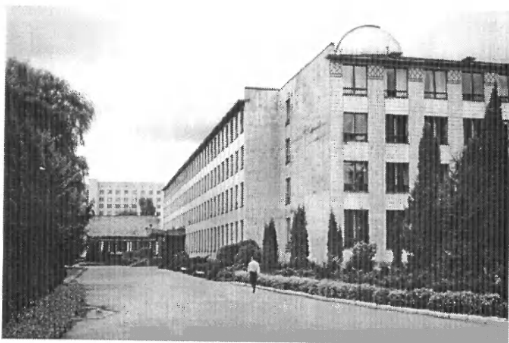
Новий корпус педуніверситету.
