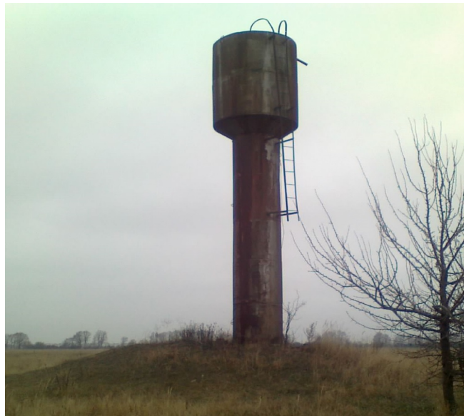
Рис. 7. Водонапірна башта в с.Бакаївка
