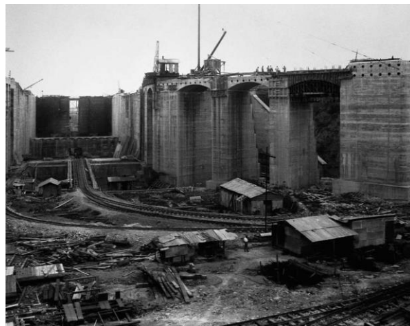
8 серпня 1913 року. Будівництво шлюзу Гатун між Атлантичним океаном і озером Гатун.
