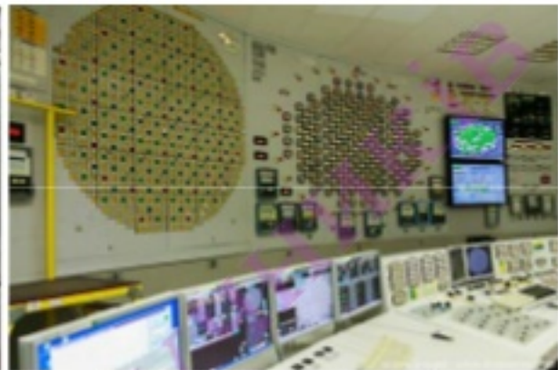
Мал. 4.17. Пульта управління реактором
