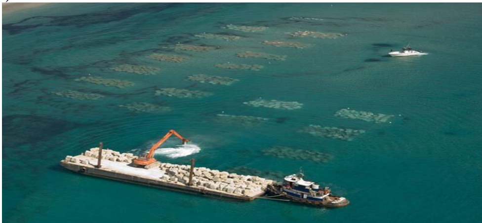
Рис. 184. Будівництво штучних островів
