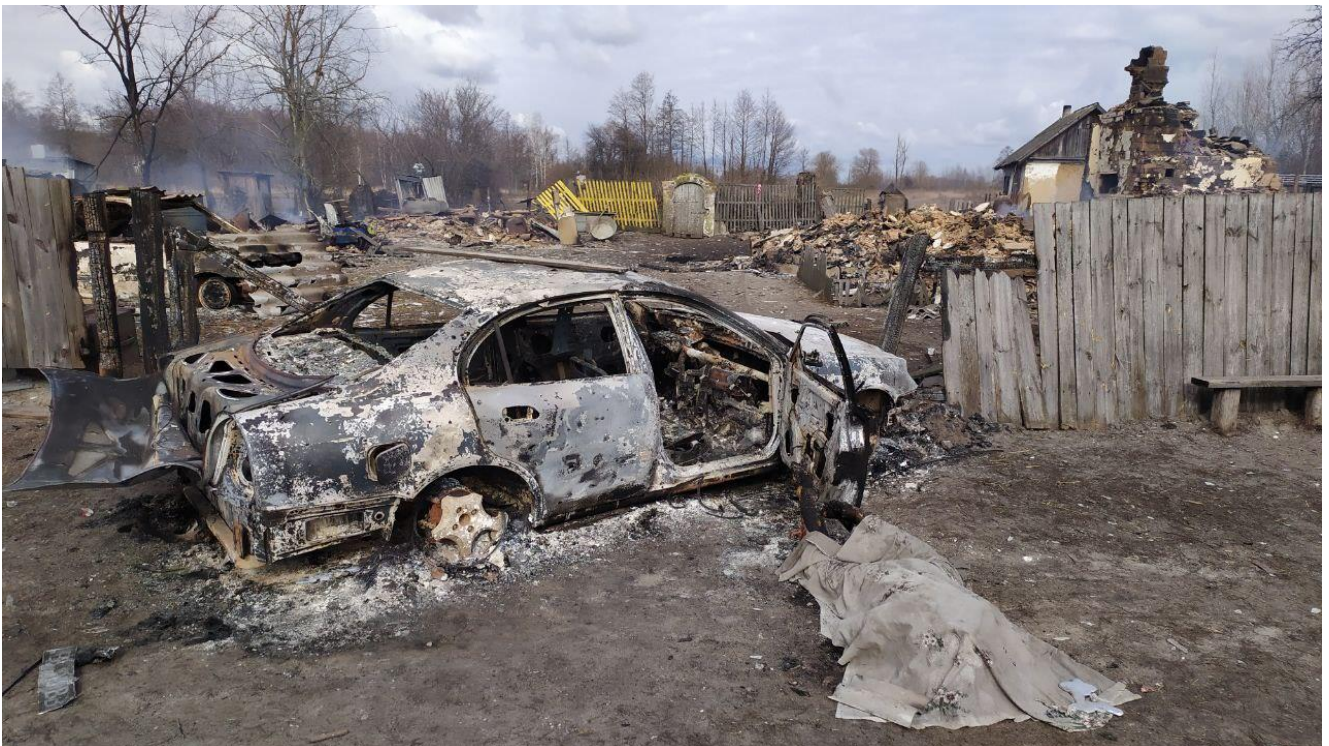
Руїни хати і спалена окупантами машина у селі Крупичполе. Фото місцевого мешканця, березень 2022 року.
