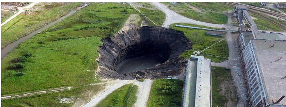
Рис. 179. Техногенний провал над порожнинами шахти з видобутку калійної солі
